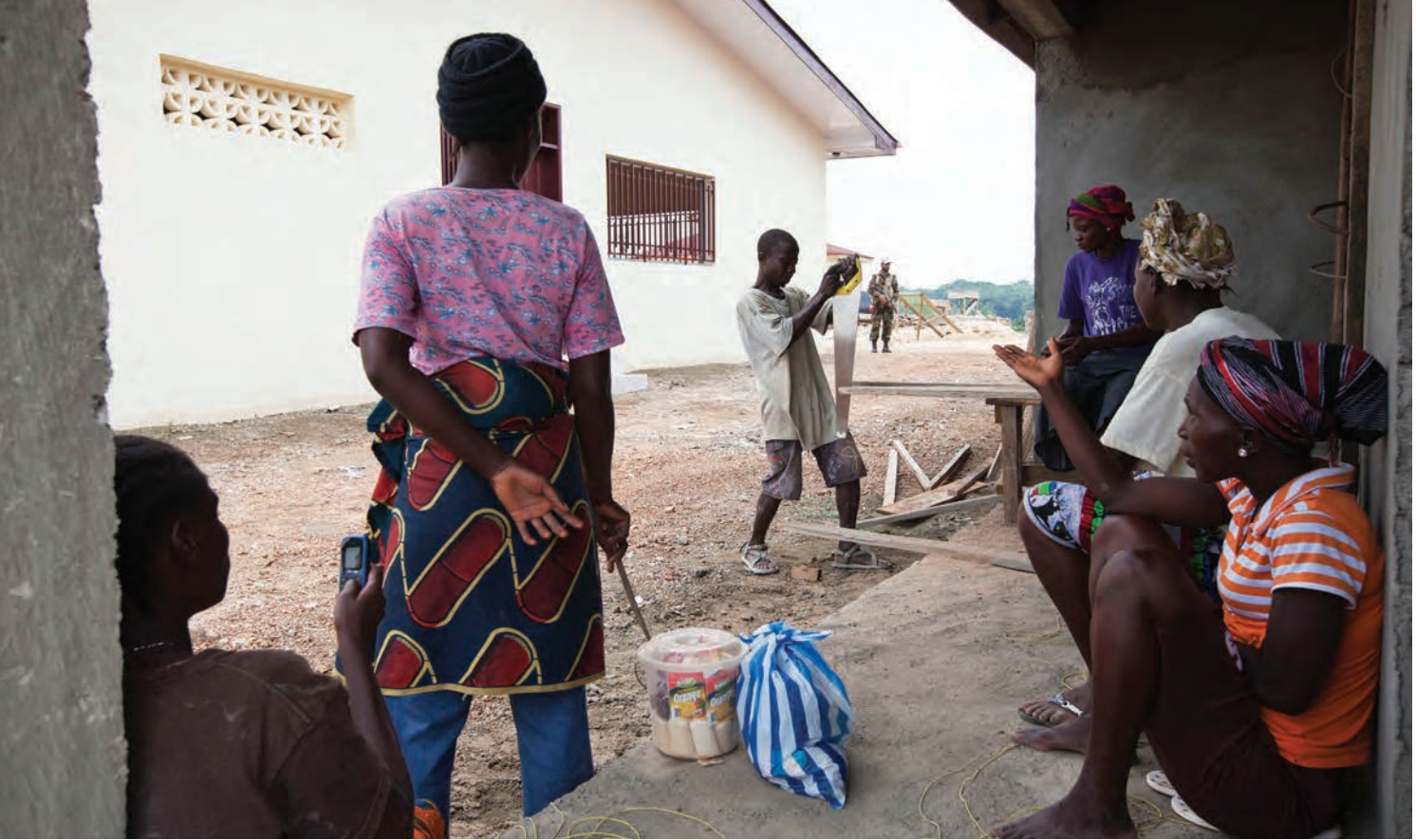
Construction d'un centre pour la paix et la justice à Gbarnga au Libéria. Cette nouvelle initiative est financée par le Fonds des Nations Unies pour la consolidation de la paix. Crédit : Photo ONU /Staton Winter
